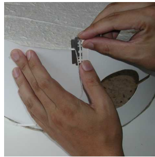
Abb. 18 Feinschnitt mit Rasierklinge
